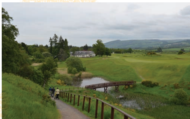
Il ponte sul vallone della 18
